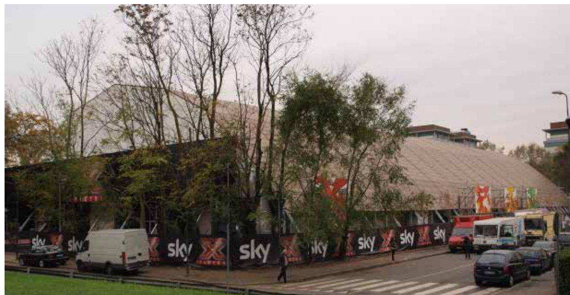
La tensostruttura della X Factor Arena ha un peso complessivo di circa 210mila Kg. Foto Alessandro Minissi
